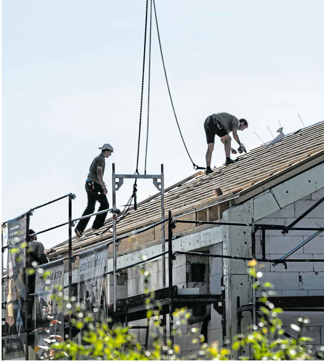
Baustelle eines Wohnhauses. Die Zahl der Baugenehmigungen sinkt rapide.
